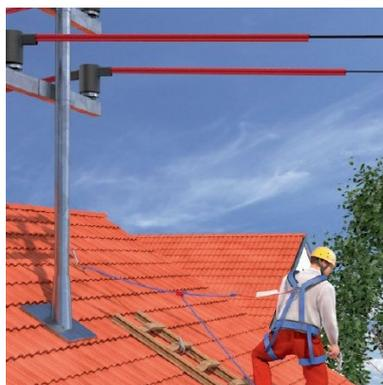
Même en présence de matériaux qui sont mauvais conducteurs, il peut exister, en cas d'humidité, un risque d'électrisation par contact indirect. Veiller à ne travailler qu'à proximité des conducteurs aériens sous-tension – il faut mettre les lignes électriques hors tension et les maintenir dans cet état pour la durée des travaux
