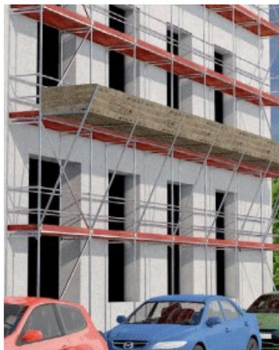
Sécuriser les zones de danger aux abords de chantiers de construction (p. ex. tours, travaux en hauteur) contre tout accès. Si cela s'avère impossible, prévoir des toits ou filets de protection à ... l'extérieur du chantier:
