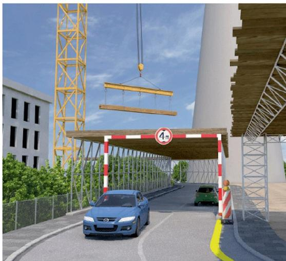
Sécuriser les zones de danger aux abords de chantiers de construction (p. ex. tours, travaux en hauteur) contre tout accès. Si cela s'avère impossible, prévoir des toits ou filets de protection à ... l'extérieur du chantier:
