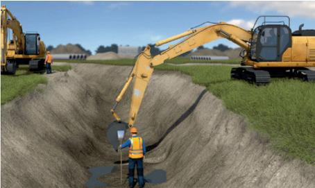
On peut creuser des fouilles en tranchées avec des parois verticales sans blindage jusqu'à une profondeur de 1,25 m, si :
